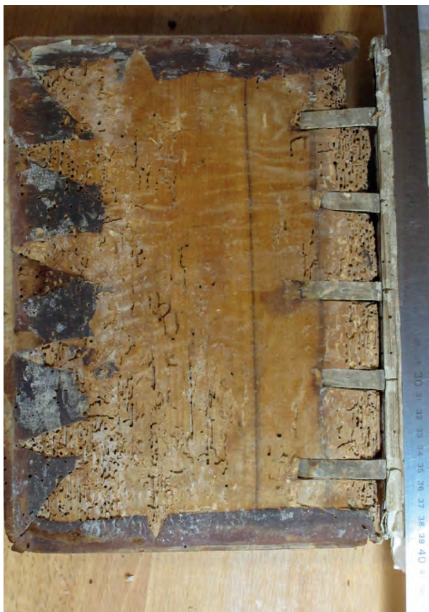
en cours: : Vue interne du plat supérieur. beaucoup plus de dommages causés par des insectes sont visibles après retrait de la contre-garde.
