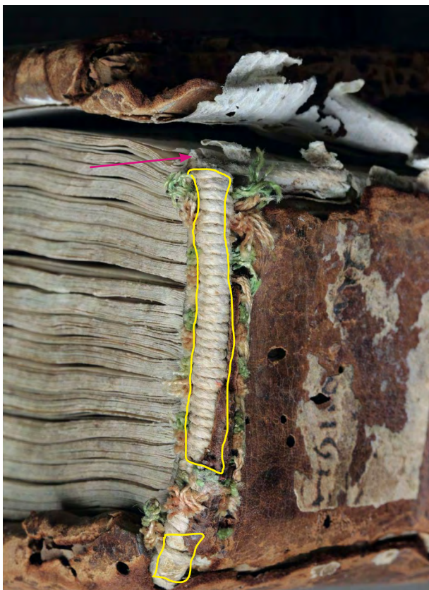
avant: Vue de la tranchefile de tête. Les fils de broderie colorés sont lacunaires dans les zones qui ont été abrasées (en jaune). Le bâti est rompu au mors supérieur (voir flèche rouge)
