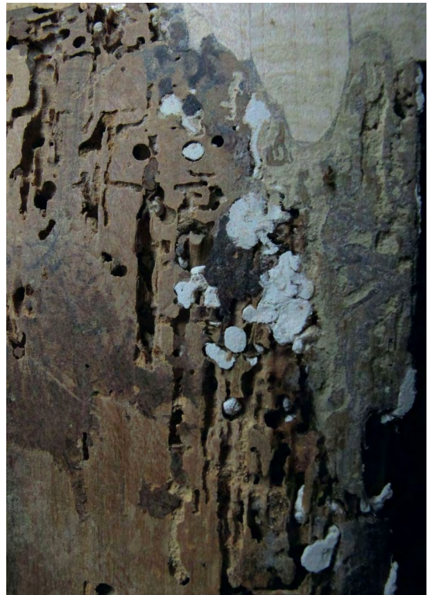
en cours: La pâte introduite par une face de l'ais ressort de l'autre côté : la consolidation est donc effective sur toute la longueur des galeries.
