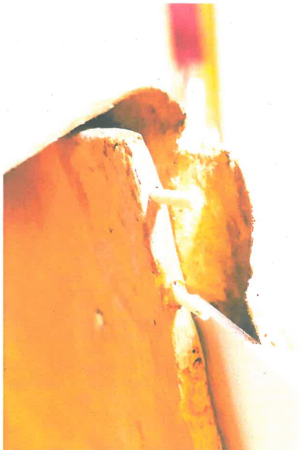
après: les fragments du coin ont été recollés et consolidés par deux bâtons en bois (flèches)
